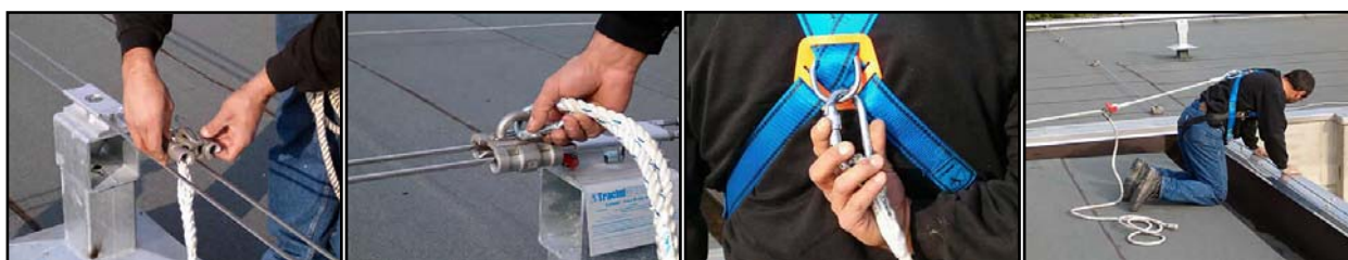
Esempio di aggancio dell'imbracatura di sicurezza alla linea di ancoraggio
